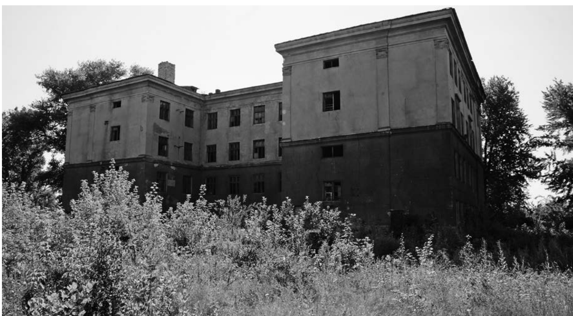
Здание школы в поселке Торцевский
