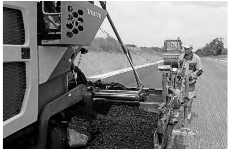
Завершается ремонт трассы по маршруту Славянск – Бахмут
