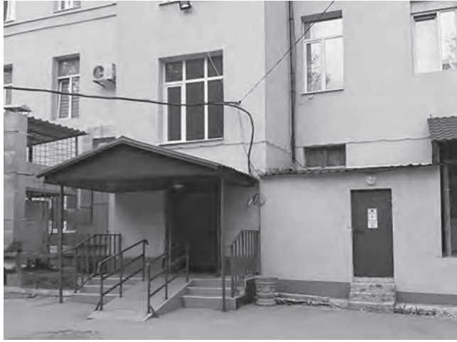
Горбольница № 5 в Константиновке после ремонта
