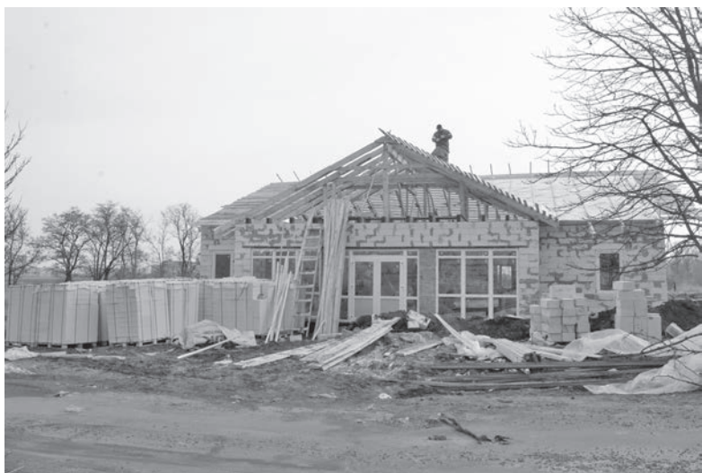
Строительство амбулатории в Ильиновке – в самом разгаре
